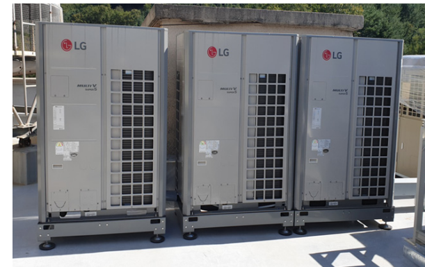
냉난방 설치 사진
