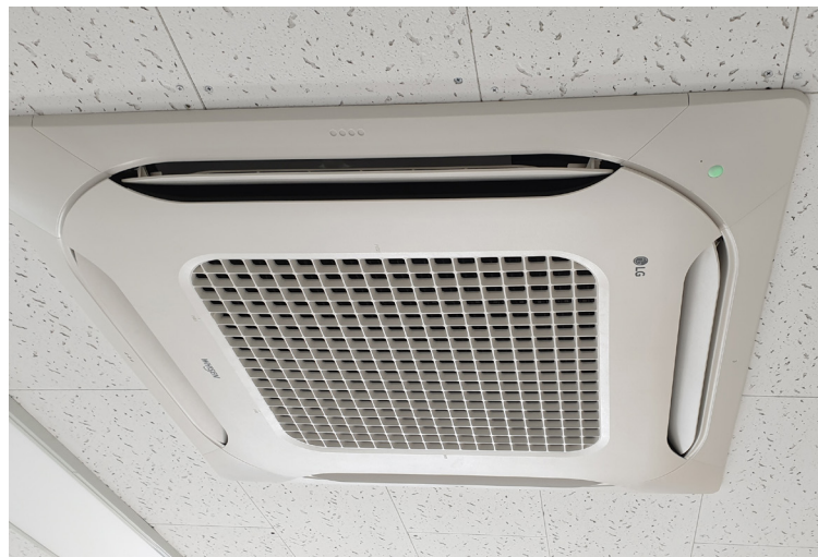
냉난방 설치 사진
