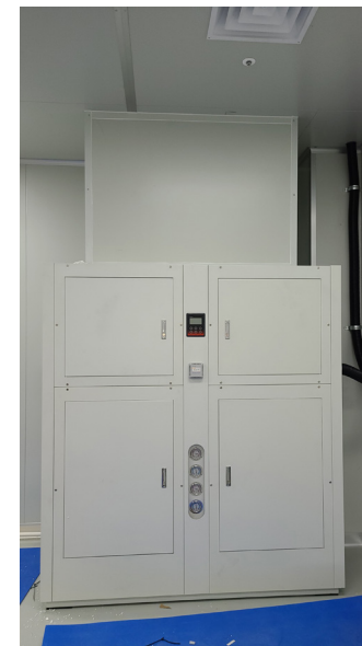
향온 흡습기 설치 사진
